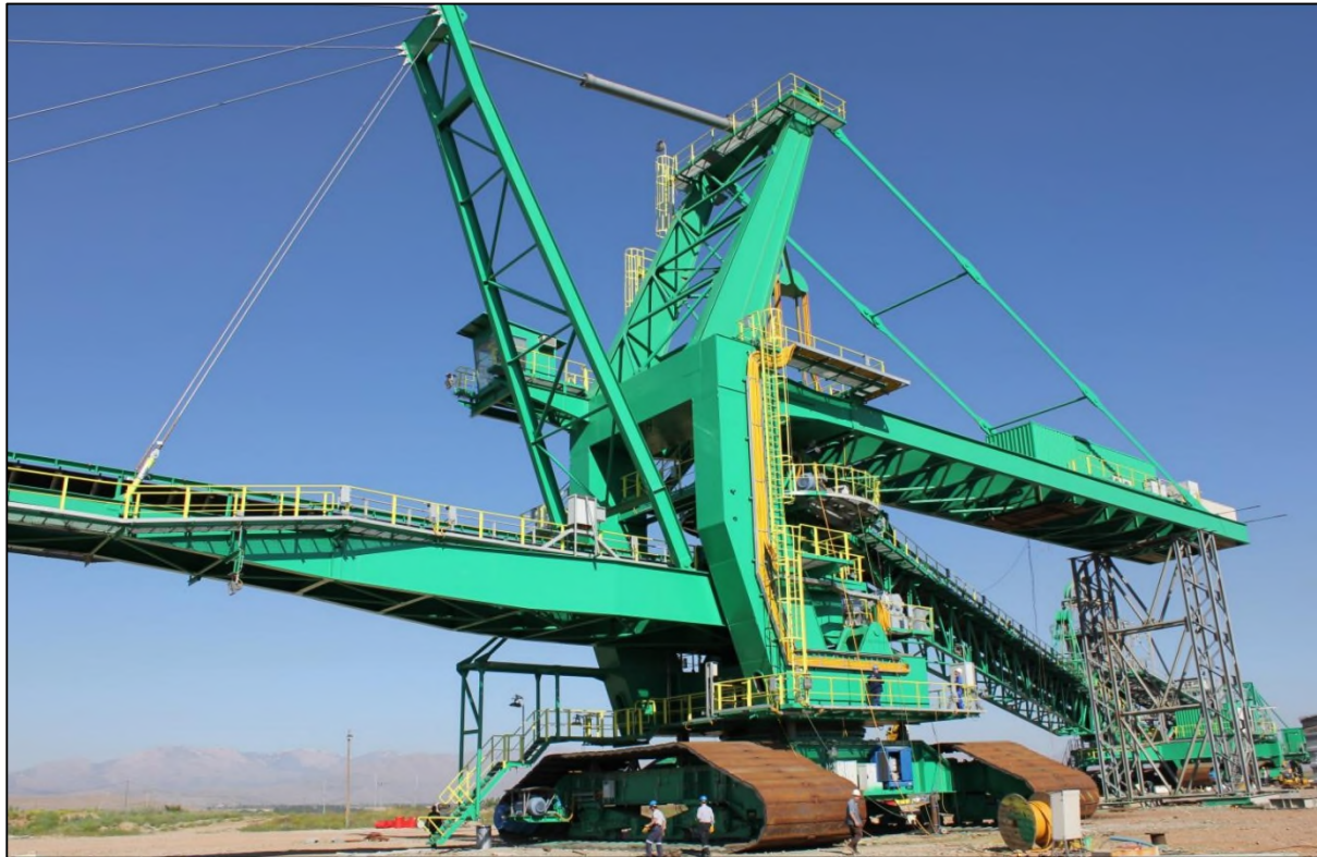
Abbildung 2: Montagearbeiten an einem Absetzer 54
